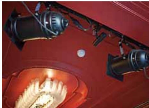
Im Roten Saal der Volksbühne (unten) installierte Elektro Jahn Funkrauchmelder, in der Kassenhalle (links) kamen ebenso wie im Großen Haus (oben) linienförmige Rauchmelder zum Einsatz.
